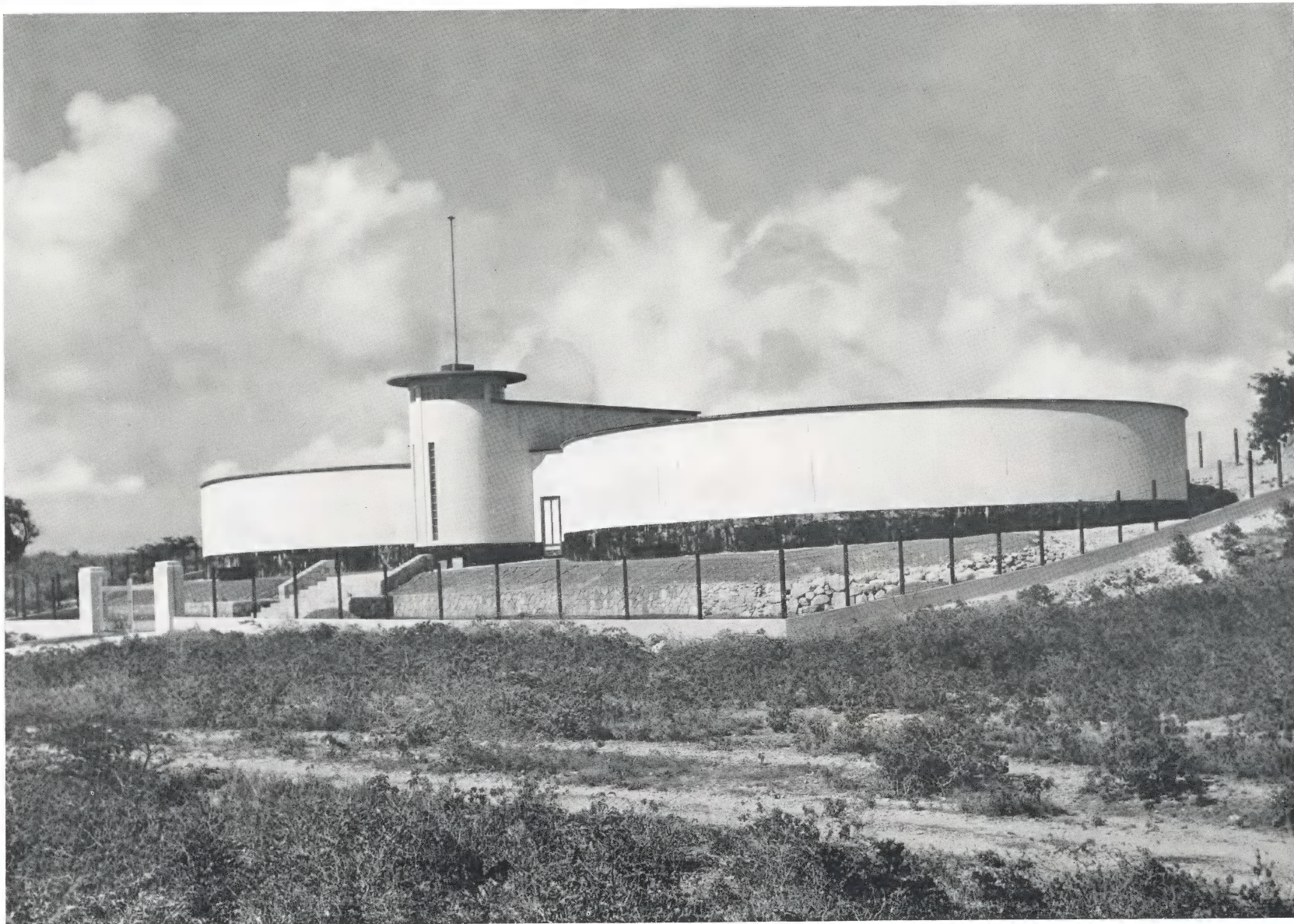
HET VOORRAAD-RESERVOIR SCHARLOO (INH. 4000 M 3 ) E DEPOSITO DI AWA NA SCHARLOO (CONTENÍDO 4000 M 3 ) WATER-STORETANK AT SCHARLOO (CAPACITY 4000 M 3 )
